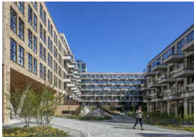
Verdichting aan de andere kant van de Maassluisstraat
