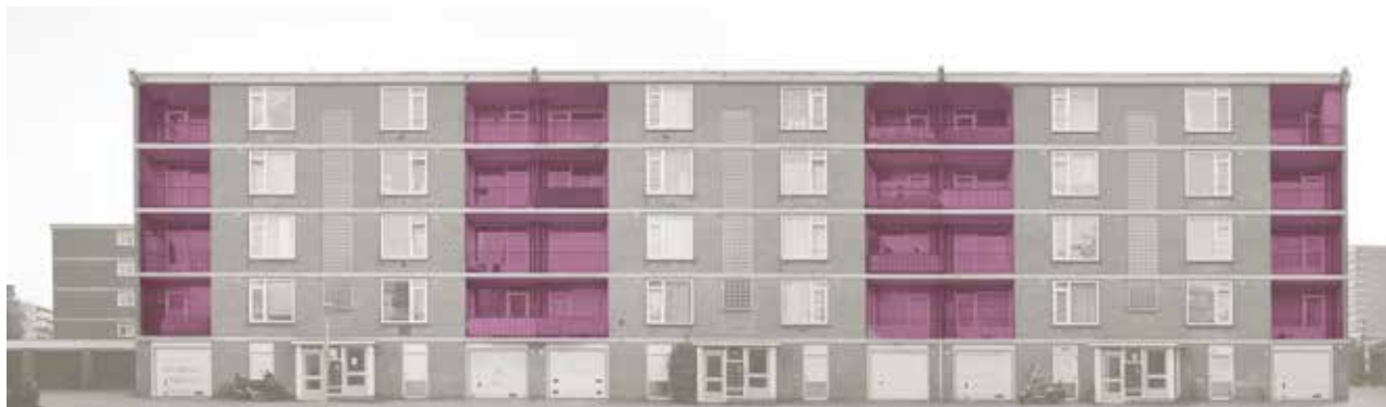
Gevelaanzicht in een van de tussenstraten; kenmerkend zijn de doorlopende horizontale banden, de sterke ritmiek en de plasticiteit die ontstaat door de loggia's en trappenhuizen.
