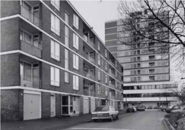
De bestaande gevels van zowel de stroken als torens zijn ontworpen met doorlopende horizontale gevelbanden
